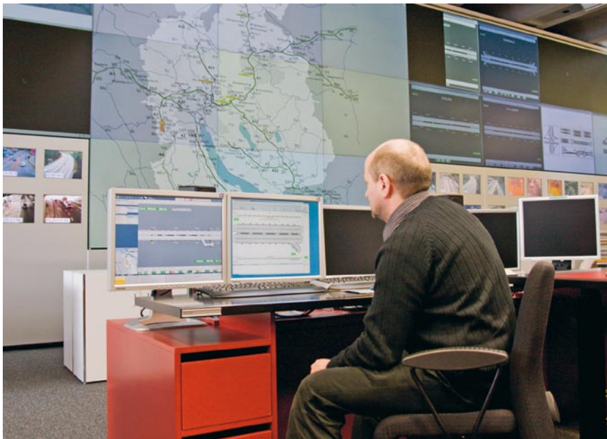
Bild 2 UeLS-Bedienstation in der Betriebsleitstelle Urdorf.
